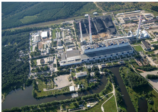
Zdjęcie 1. Teren Elektrowni Dolna Odra z lotu ptaka
