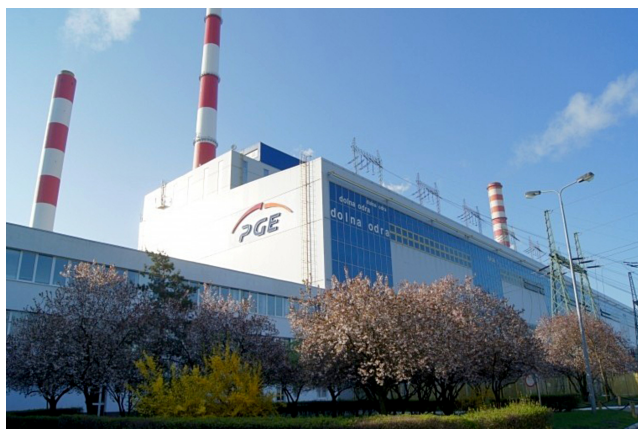
Zdjęcie 2. Elektrownia Dolna Odra
